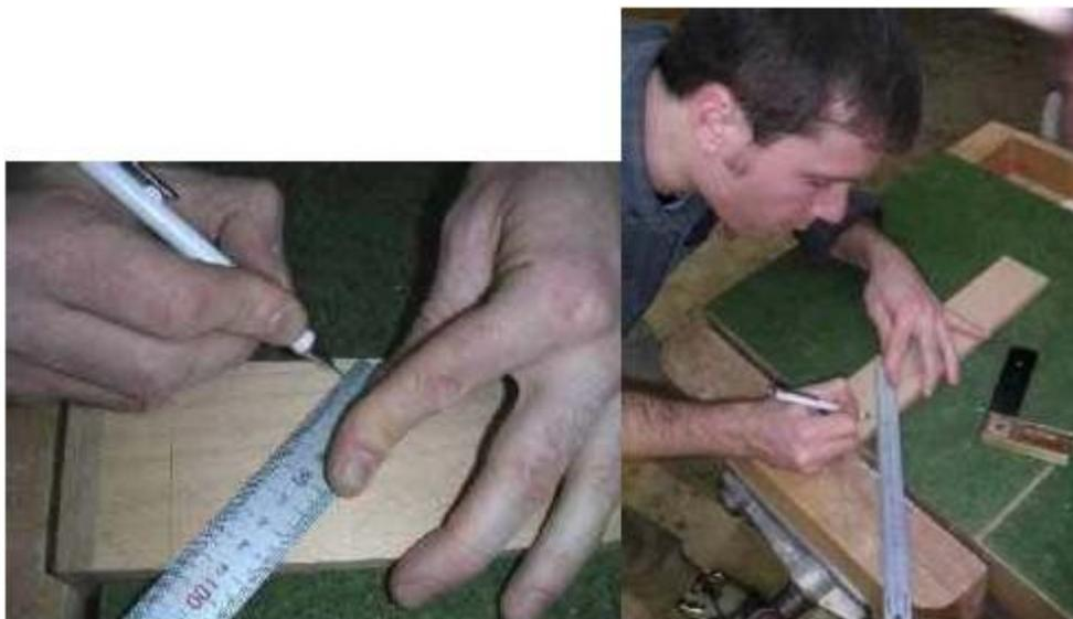
**Agora a partir deste risco de 24mm, se faz um risco na diagonal (veja a foto), este risco tem que ser da seguinte forma: a partir da ponta do risco de 24mm, usando a régua ou o metro, traça-se um risco na diagonal. O comprimento deste risco é de acordo com a largura da peça (lados da gaveta), no caso eu tenho aqui uma peça de 75mm e este meu risco de 100mm.**
