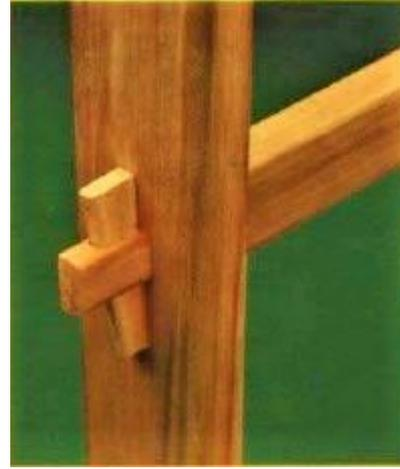
**Foto 3.** Esta variação de união por cunha é muito adequada para a montagem de aros de portas. A parte larga da mesa coincide com as dimensões da caixa e evita que se produzam desvios laterais.
