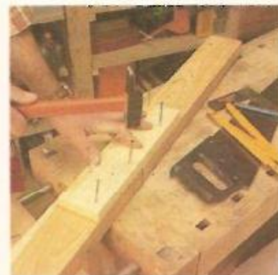
5. Colocação da primeira placa de reforço
