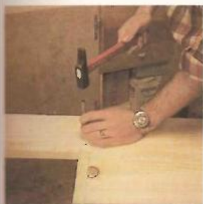
13. Cravagem dos pregos
