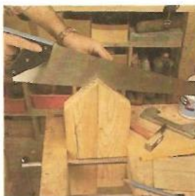
3. Execução dos entalhes
