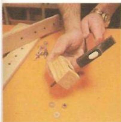
10. Colocação do parafuso no calço
