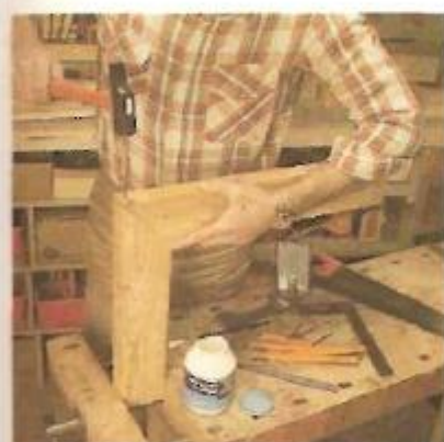
2. Colocação de pregos de reforço
