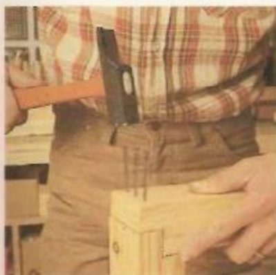
3. Colocação dos pregos de reforço
