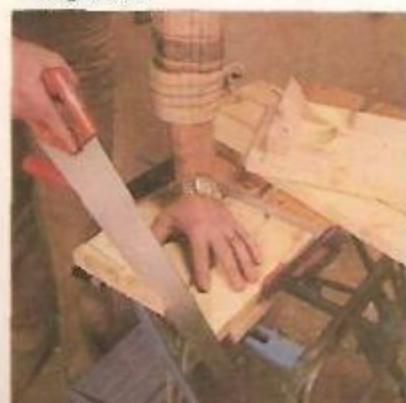
7. Corte segundo o traçado
