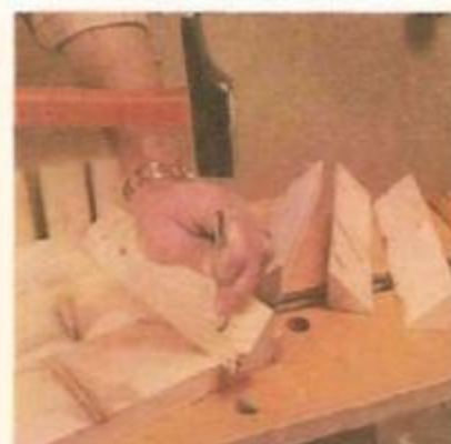
4. Primeira fixação dos suportes angulares
