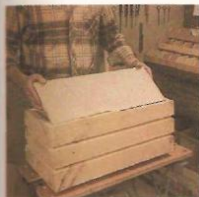
11. Colocação do fundo
