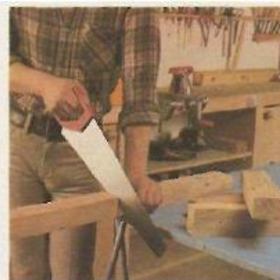
3. Serragem dos montantes
