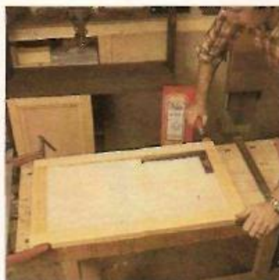
17. Montagem de uma porta
