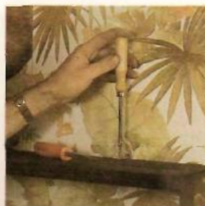
24. Fixação da parte superior do móvel
