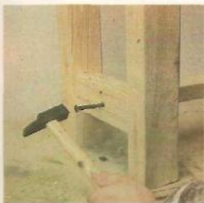
19. Introdução dos parafusos
