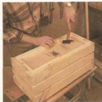
12. Fixação do quadro de suporte
