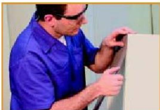
3. Aplique o silicone à base d'água na superfície do móvel
