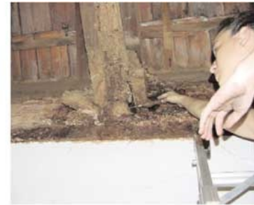
Estrutura de telhado de madeira infestada por cupins de solo
