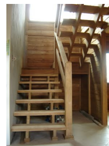
Detalhe escada e piso
