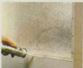
Introduzimos o acrílico no respectivo rebaixe e fixamos depois com parafusos niquelados, antes de procedermos à impermeabilização de traseira.
