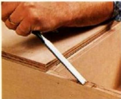
**16** Arrancamos com um formão a madeira que determina o assentamento dos pernos.
