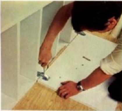
**15** Fixamos as portas com dobradiças invisíveis depois de colocarmos e marcarmos sua posição correta. Devemos utilizar parafusos especiais para aglomerado (com hélice regular até a cabeça).
