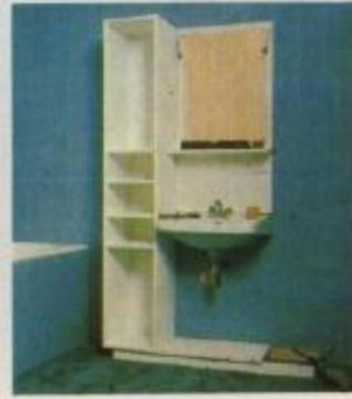
Depois de montar a base (soco) colocamos a estante da esquerda, construída por um armário inferior, três prateleiras divisórias e outro armário superior. Fixamos todo este conjunto à parede de azulejos por meio de buchas e parafusos.
