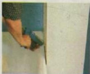
A junção entre a parede de fundo do móvel e a banheira é enchida com massa de silicone, o que permite evitar que a água se infiltre por aí.
