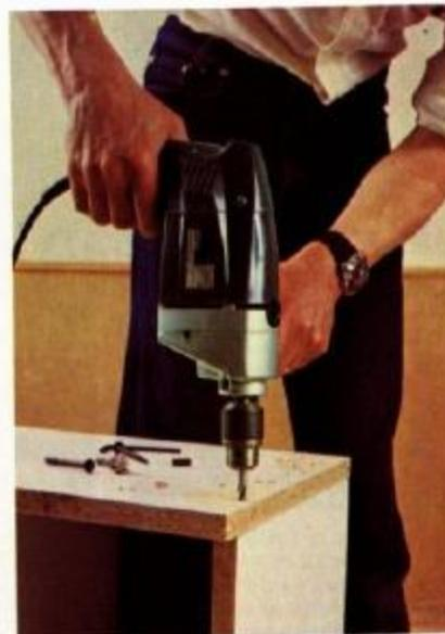
**10** A parte superior será fixada às laterais mediante fixações mecânicas. Fazemos perfurações de 6 mm até alcançarmos o comprimento da lixação (cerca de 62 mm). Devemos atravessar de uma só vez o montante e a prateleira.
