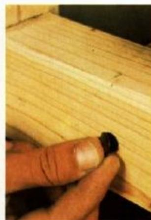
**22** A cabeça da fixação fica escondida atrás de um tampão de plástico que imita a cabeça de um prego forjado.
