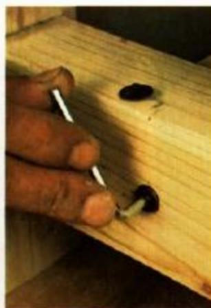
**20-21** Introduzimos o cano de fixação e aparafusamos a cabeça com uma chave hexagonal que acompanha as fixações.
