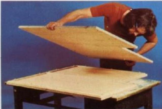
**5** As partes da frente e a lateral do bar são forradas por tampos gêmeos unidos a uma régua de separação, com 5 cm de espessura.
