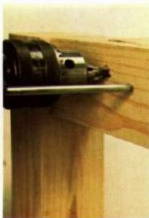
**19** Fazemos as perfurações para as fixações de 6 mm dos elementos. Escariamos ligeiramente para assentar a cabeça do parafuso.
