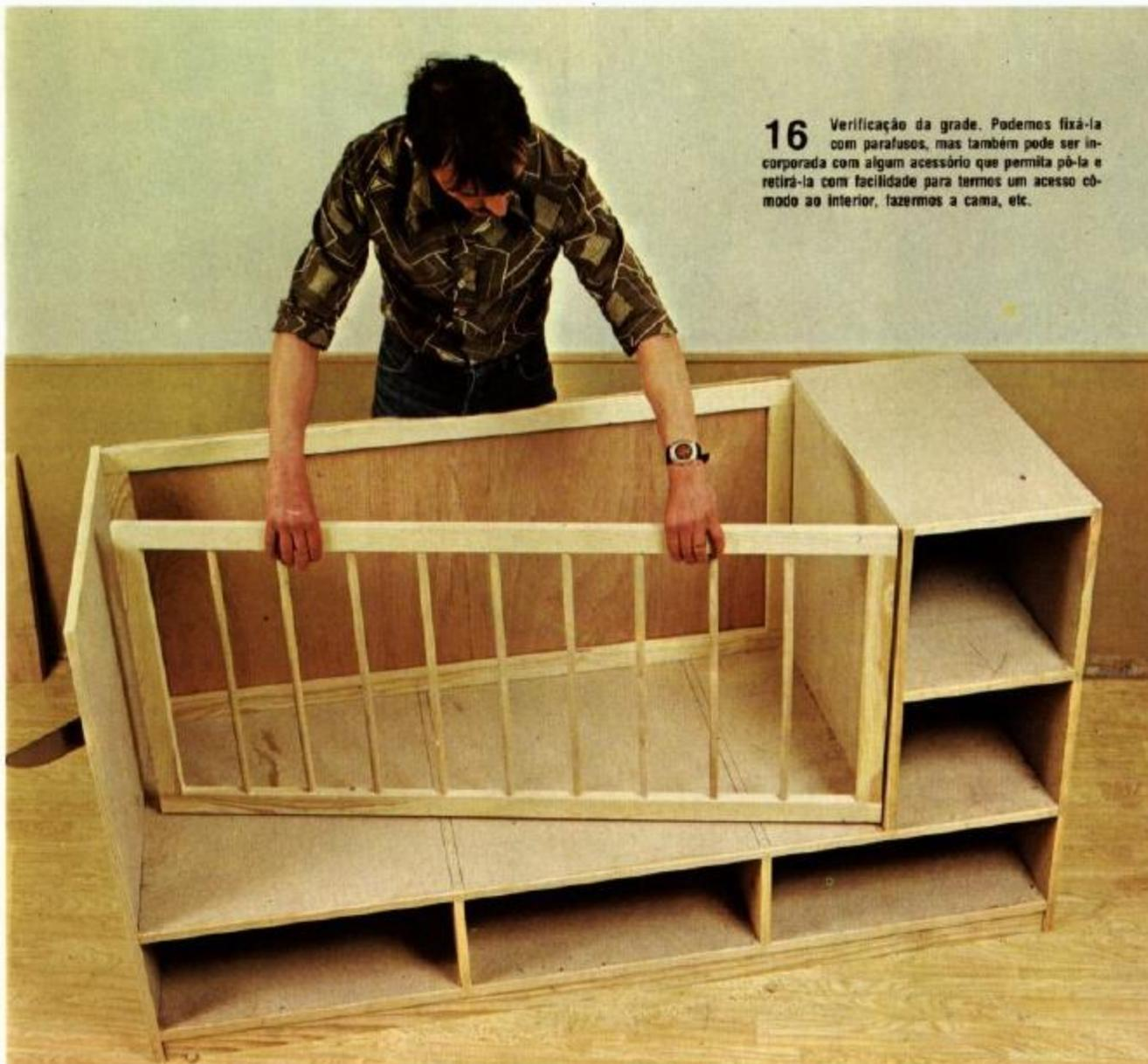
**16** Verificação da grade. Podemos fixá-la com parafusos, mas também pode ser incorporada com algum acessório que permita pô-la e retirá-la com facilidade para termos um acesso cômodo ao interior, fazermos a cama, etc.
