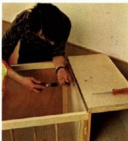
**17** Fixamos uma prancha auxiliar de dimensões iguais à tampa do pequeno armário com uma dobradiça do piano. Desdobrada sobre a cama, será um excelente plano para trocar a roupa da criança.
