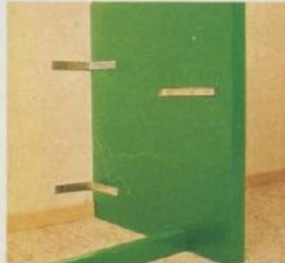
A armação é presa na parede através de esquadros metálicos e tacos. Se desejarmos que o móvel fique livre teremos que incorporar um encosto que tenha muita estabilidade.
