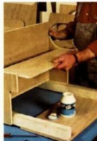
**11** Recortamos no comprimento e largura a tábuas que servirá de assento, fixando-a diretamente com cola e parafuso.
