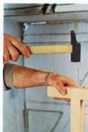
**4** As traves inferiores são colocadas na parte de dentro dos montantes e pregadas pelo lado de fora, a 10 cm da extremidade inferior dos mesmos montantes.
