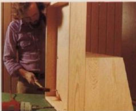
A peça traseira é unida à parte inferior da escada com parafusos pretos de cabeça redonda e pescoço quadrado de 8 mm de grossura. Os furos serão previamente feitos.
