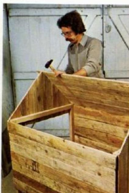
**15** O telhado é pregado sobre os cantos das tábuas da fachada e da parte de trás.
