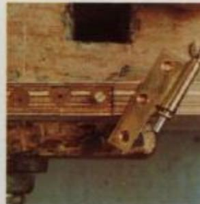
**11** Os parafusos das dobradiças não oferecem muita solidez em placas de compensado. Convém inserir espigões transversais.
