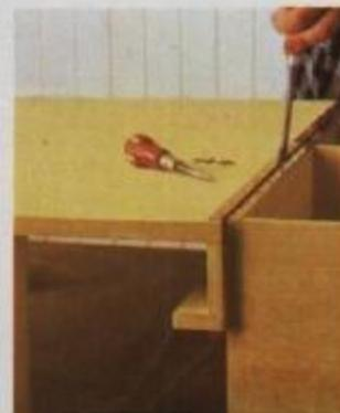
**5** O painel de abater e a estrutura são unidos por uma dobradiça de plano, aparafusada primeiro ao painel e depois à estrutura.
