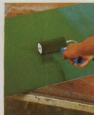
**12** Em seguida lixamos toda a superfície e aplicamos duas demãos de tinta especial para quadro negro, utilizando um rolo.
