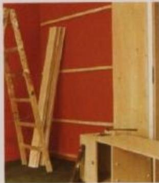
Depois de aparafusar perfeitamente as régulas à parede, fixam-se as tábuas de esquadria, operação que não apresenta problemas.
