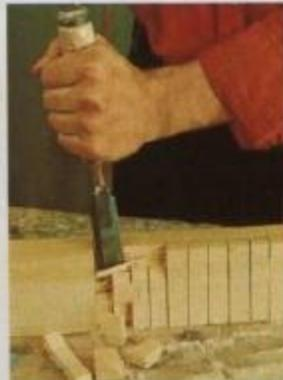
**2** Para abrir os encaixes no pé da mesa e no suporte do tampo, fazemos primeiro vários cortes de 15 mm de profundidade, de 2 cm em 2 cm.
