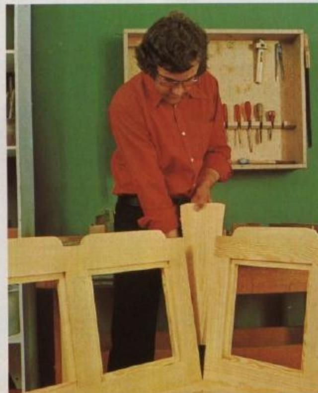
**13** Depois de montada a moldura do assento, está concluída a parte principal do banco de canto. Falta apenas fazer a junção das duas costas por meio de uma peça previamente ajustada e que é colada e aparafusada às duas partes.
