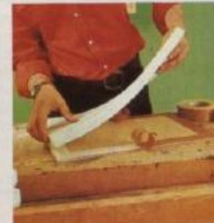
**14** A placa de espuma de plástico do forro é pregada aos painéis de compensado com fita adesiva de duas faces.
