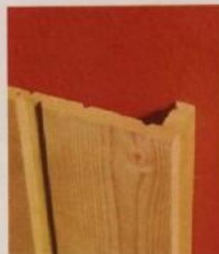
Cobre-se com uma ripa o espaço lateral que fica entre a tábua e a parede. Se a moldura da porta sobressai, a construção pode-se eliminar.
