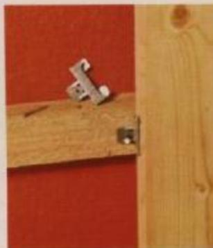
Cada tábua é pregada ao longo do rebaixe, ficando assim a fixação tapada com a outra tábua. Fácil de realizar com ferramentas apropriadas.
